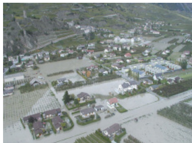
Photo 2: Rupture de digue et inondation. Rive droite du Rhône, Fully, octobre 2000.
